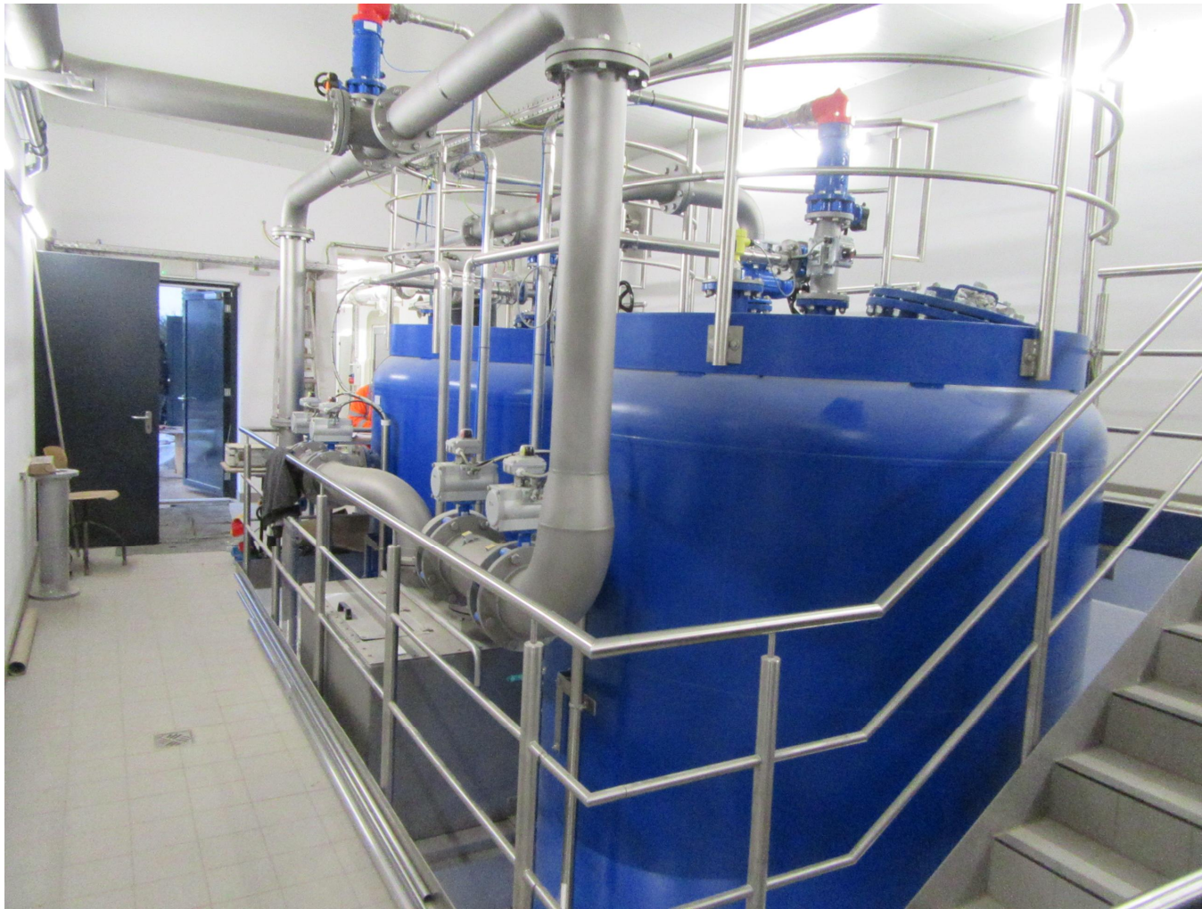
Innenausbau Neubau Wasserwerk Eschau
