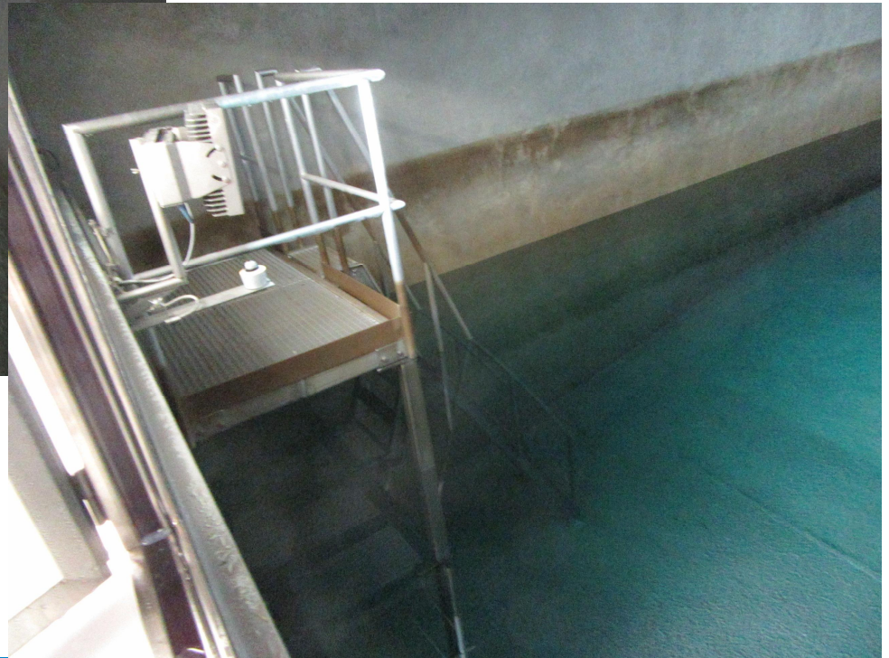
Blick in die Wasserkammer des Hochbehälters Eschau
