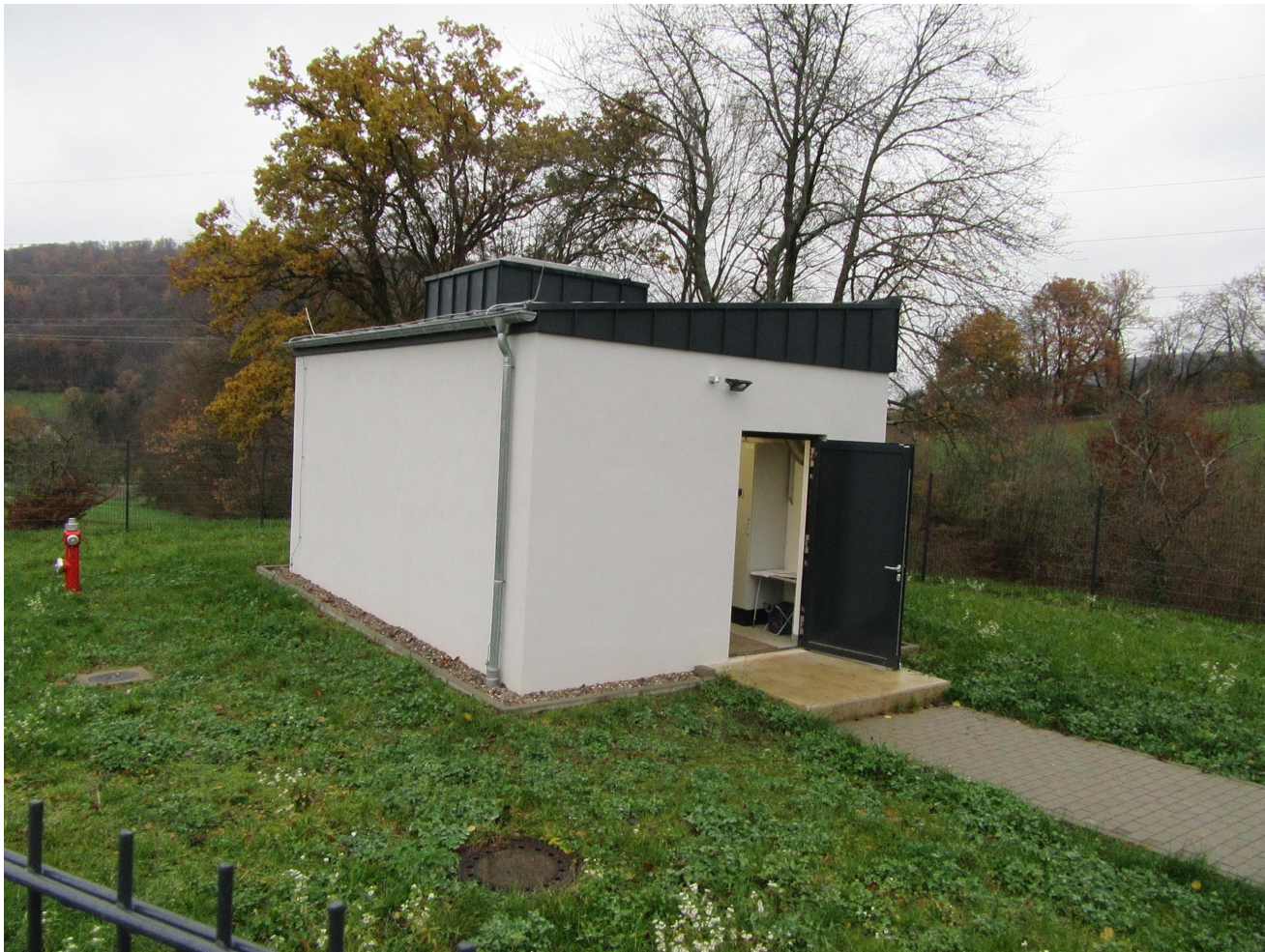
Fertiges Brunnenabschlussbauwerk - Vorderseite
