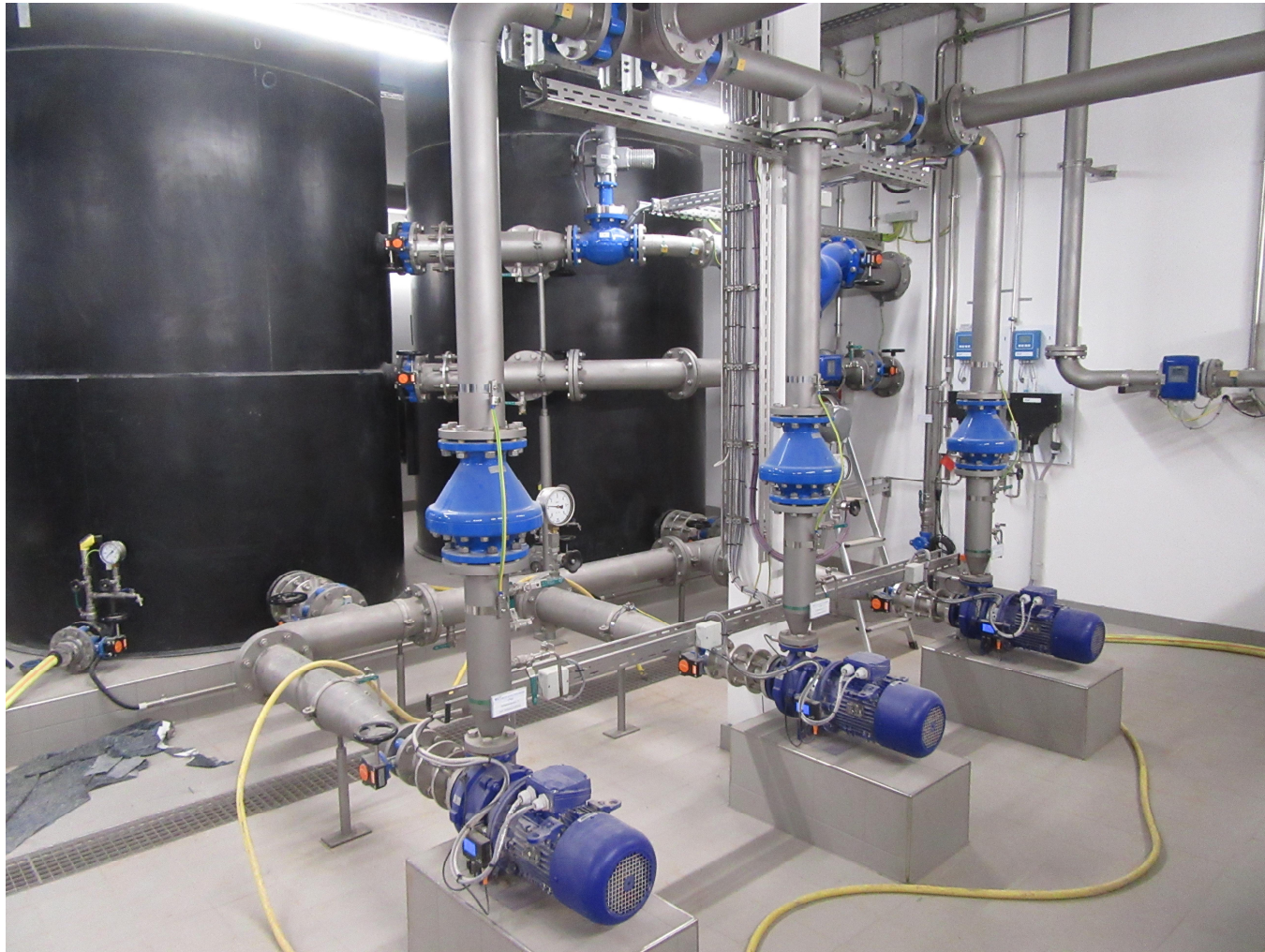
Innenausbau Neubau Wasserwerk Eschau
