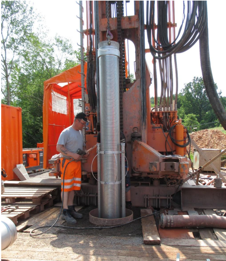
Einbringen der Voll- und Filterrohre aus Edelstahl - DN 300
