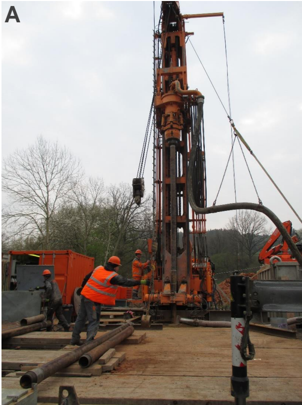
A: Bohrgerät mit Schwerstangen
